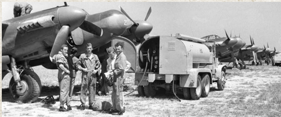
Аутомобил цистерна за гориво ССКВ 353 од 4.000 л за појуну горивом авиона „москићо Мк38“ из 103. извиђачког пука, 1955. године на аеродрому Бањајнци
